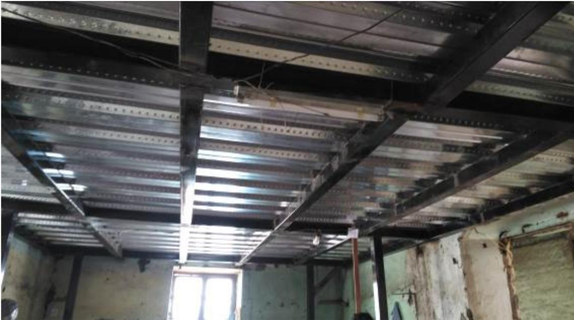
La cubierta de la residencia es de estructura metálica y cubierta de plástico, la cual se apoya en los muros de adobe.
